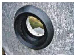
4. Mit einem Maßstab die Wandstärke messen und eine Markierung am Rohrende anbringen. Die Dichtung mit Gleitmittel einstreichen.
