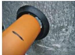
5. Das Rohr bis zur Markierung einschieben.
