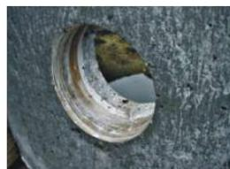
3. Die Dichtung (Schachtfutter) bis zum Anschlag einpressen. Dabei kein Gleitmittel verwenden!
