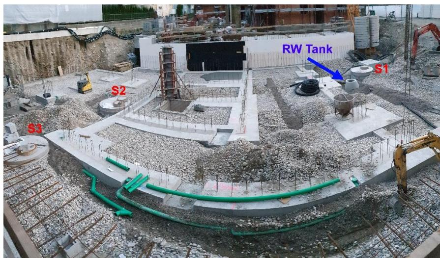
Versickerung (S1-S2-S3) und Regenwasserspeicher
