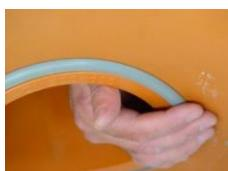
9. Hohlraum durch die Öffnung mit dem Expansionsharz ausfüllen. Die Qualität des Anschlusses hängt maßgeblich vom Einsatz der richtigen Werkzeuge ab. Ein korrekter Einbau des Sattels ist nur mit Kronenbohrer und Gewinderadschlüssel möglich.
