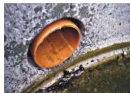
6. Verificare che il tubo da collegare non si estenda all'interno del pozzetto.
